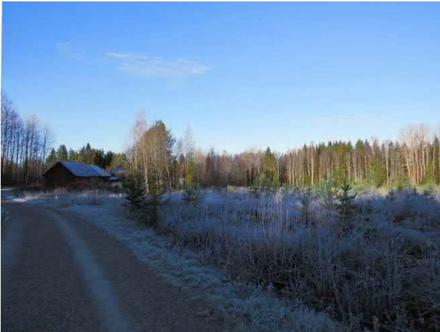
15. Johtoreitti Nurmonjoen itäpuolella, länteen.
