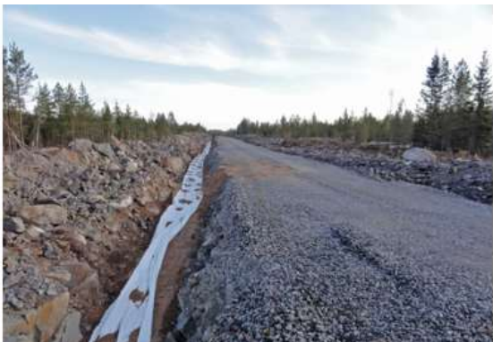
Kuva 4.17 Maakaapelit upotetaan huoltoteiden yhteyteen (FCG Finnish Consulting Group Oy).
