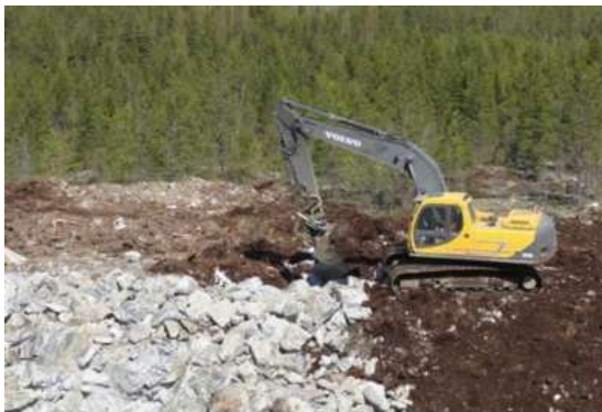
Kuva 4.16 Tuulivoimapuiston rakentaminen alkaa huoltoteiden ja pystytysalueiden rakentamisella (FCG Finnish Consulting Group Oy).
