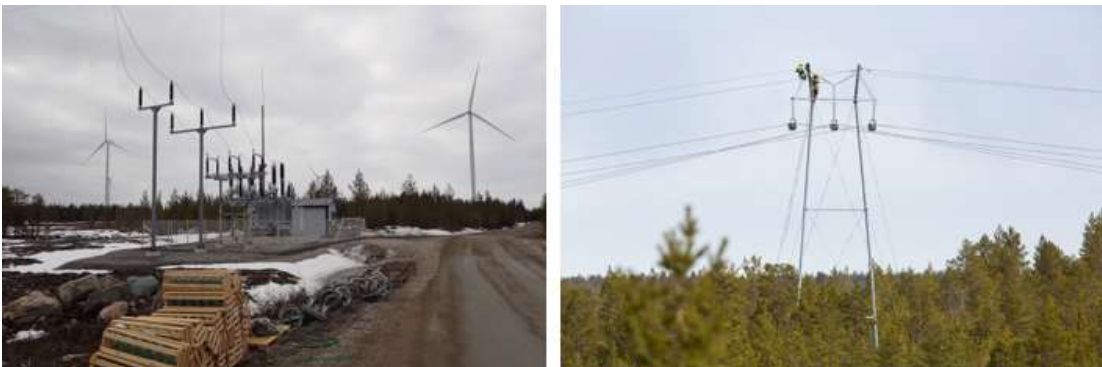
Kuva 4.21 Sähkösäntän ja voimajohdon rakentamista (FCG Finnish Consulting Group Oy).
