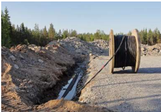
Kuva 4.17 Maakaapelit upotetaan huoltoteiden yhteyteen (FCG Finnish Consulting Group Oy).
