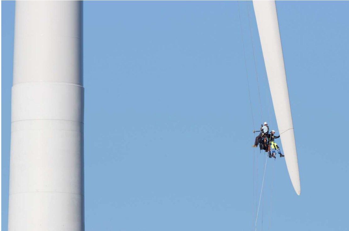
Kuva 4.23 Tuulivoimalan huoltotoimenpiteitä (FCG Finnish Consulting Group Oy).
