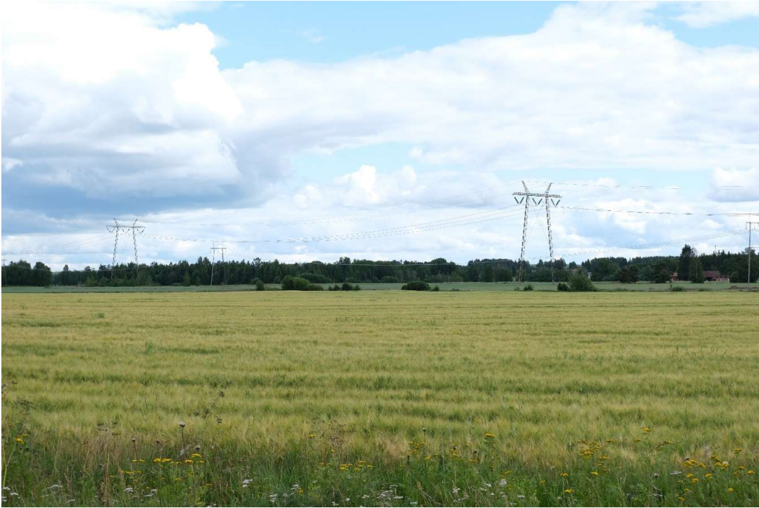
Kuva 8.42 Voimajohtojen kuvauspiste 2. Havainnekuva Nurmosta Länsitieltä sähkönsiirtoreittivaihtoehdosta SVE2B. Kuvauspistekartta on esitetty kuvassa 8.23.
