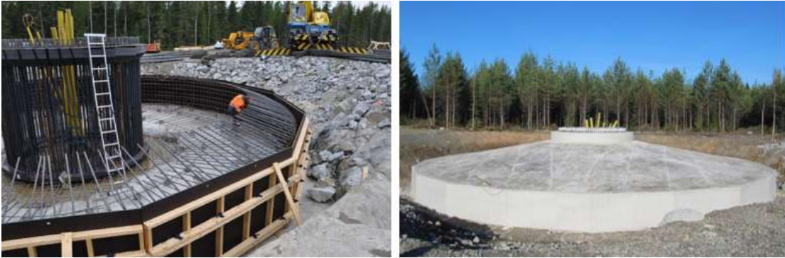
Kuva 4.18 Tuulivoimalan perustusten rakentamista (FCG Finnish Consulting Group Oy).
