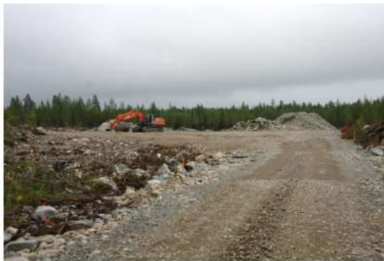
Kuva 4.16 Tuulivoimapuiston rakentaminen alkaa huoltoteiden ja pystytysalueiden rakentamisella (FCG Finnish Consulting Group Oy).
