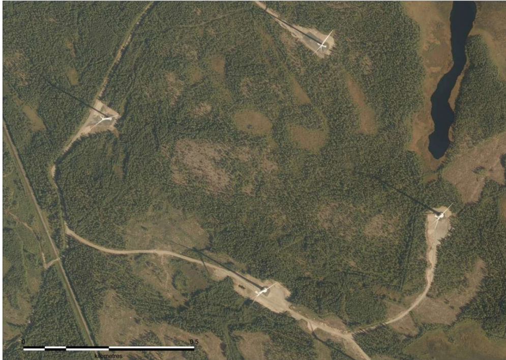
Kuva 4.1 Ilmakuva rakennetusta tuulivoimapuistosta (Maanmittauslaitos). Kuva ei ole Napalankallioiden, Hietaharjunkankaan ja Palopättäränmäen hankealueelta.
