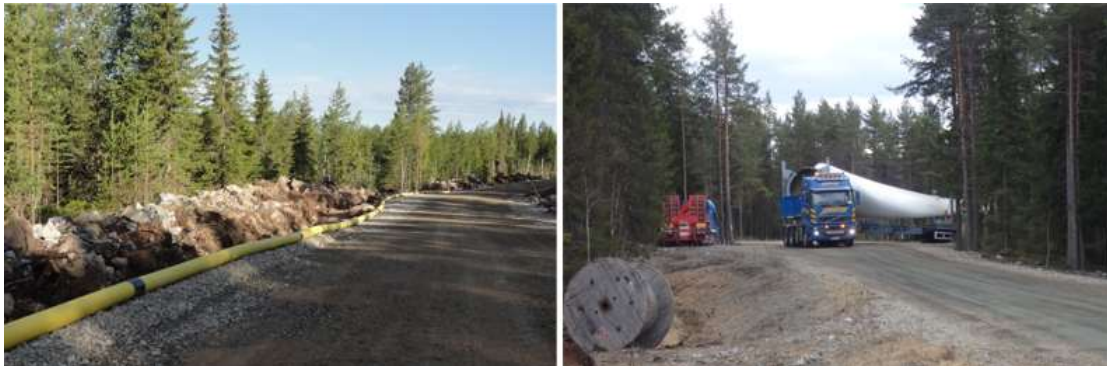
Kuva 4.8 Vasemmallä esimerkki tuulivoimapuiston rakennus- ja huoltotiestä. Oikealla tuulivoimalan osia kuljetetaan erikoiskuljetuksina (FCG Finnish Consulting Group Oy).
