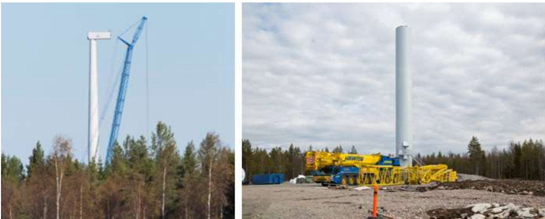
Kuva 4.19 Tuulivoimalan kokoamista (FCG Finnish Consulting Group Oy).
