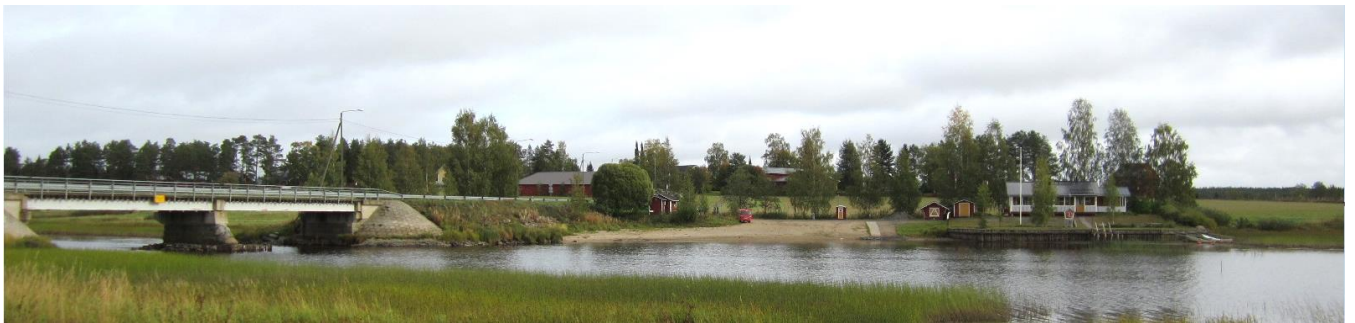
Kuva 19. Salmen silta, uimaranta ja venesatama.
