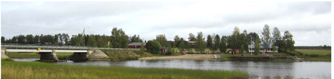
Kuva 19. Salmen silta, uimaranta ja venesatama.
